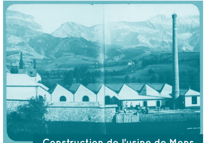
Construction de l'usine de Mens
