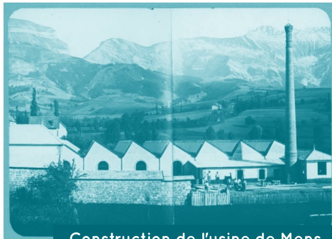
Construction de l'usine de Mens
